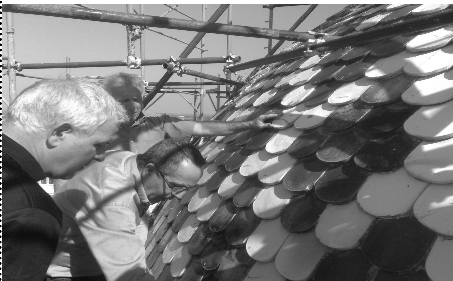
Don Gerardo mentre ispeziona i lavori sulla cupola
